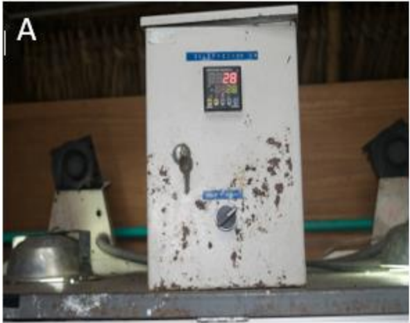
Apéndice B. Equipos de control de factores ambientales al interior del recinto. (A) Temperatura (B) Ventilación e iluminación. Tomada el 16 de mayo del 2018
