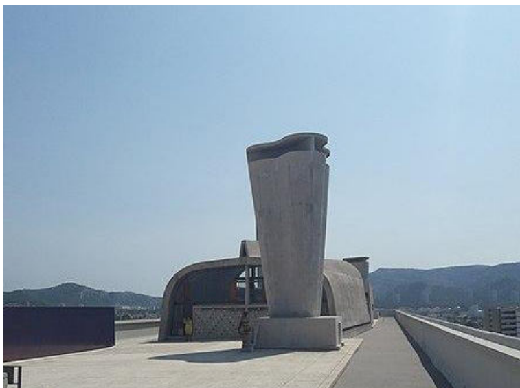
Figura 7. Terraza de la Unidad de habitación de Marsella por Le Corbusier, 1947.
